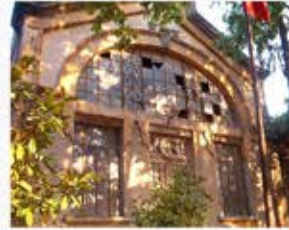
Cendere Su Pompa İst.
